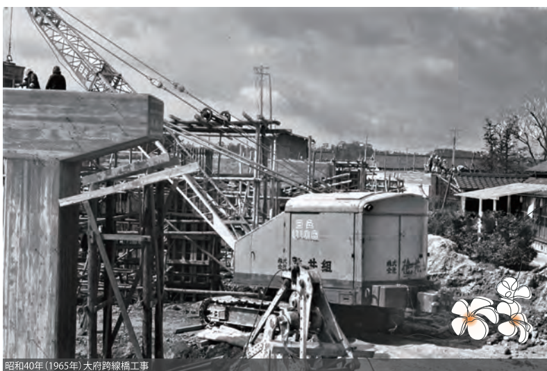
昭和40年(1965年) 大府跨線橋工事
